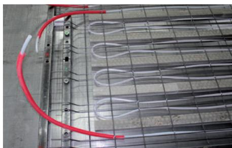
*Thermisch aktivierte Bauteile: Heizen und Kühlen durch oberflächennahen Einbau von Kunststoffrohrleitungen.*
